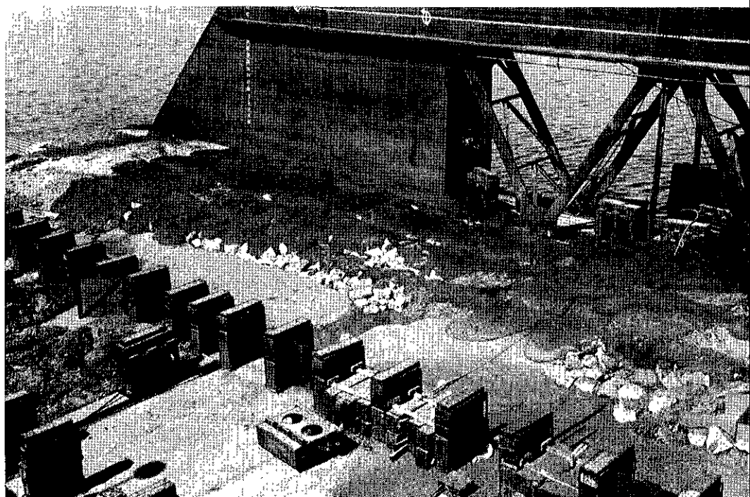
Het proefvak in het dok na het storten met vier stralen
